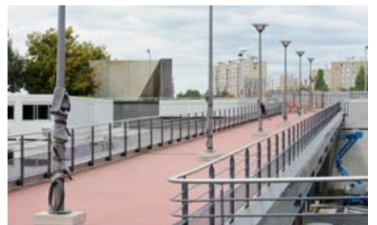
Passerelle piétonne vers l'avenue François-Mitterrand
