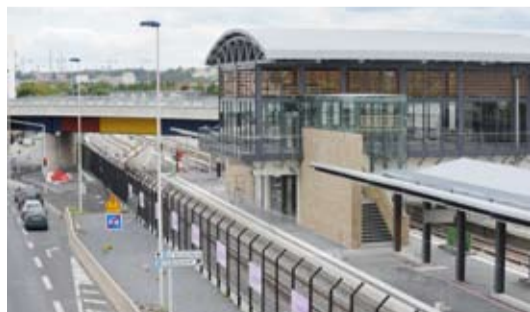
Une station terminus qui accueille locaux techniques, de signalisation et poste de commande des trains
