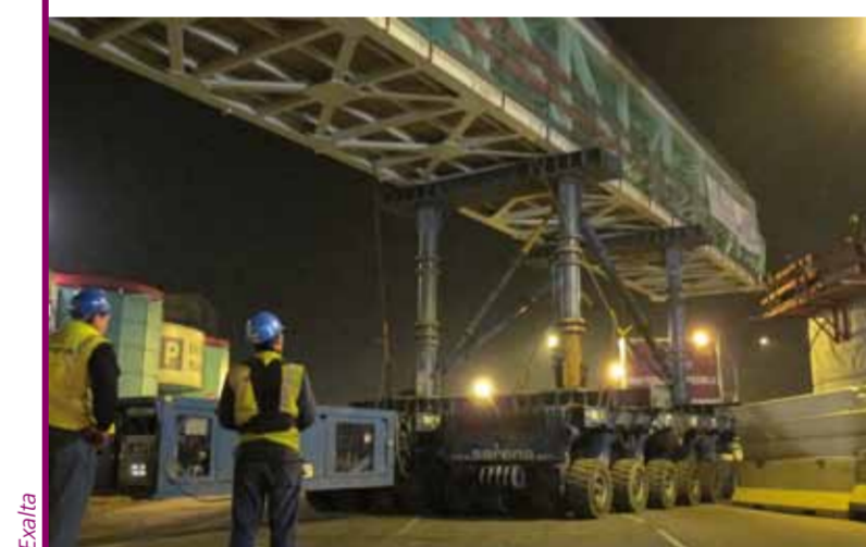
Levage de la passerelle Belle-Epine
